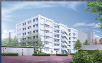
新築の女子寮 (2022年4月完成)
